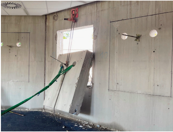
Abbrucharbeiten in der Leitstelle in Gießen für die neuen Fens- terausschnitte. Quelle: ZMW, D. Ficht
