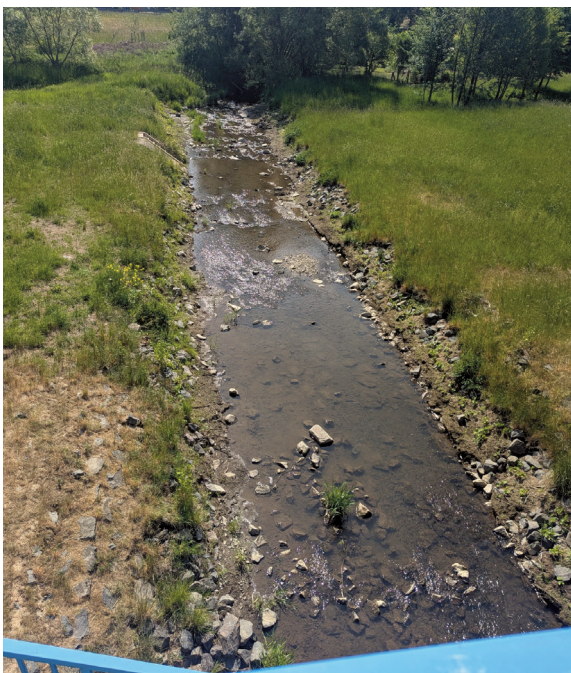
Die Salzböde im Bereich des HRB Lohra-Damm. Quelle: ZMW, Mitarbeiter der Abteilung A
