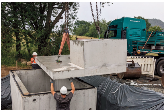
Schwerlastkran versetzt das Schachtoberteil des neuen Messschachtes von Sinkershausen. Quelle: ZMW, J. Weiser
