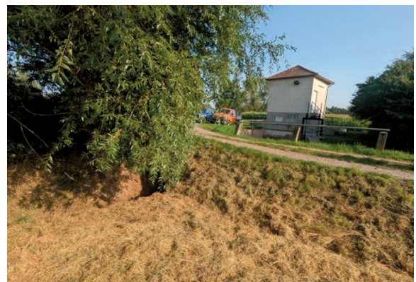
Schöpfwerk Niederwald. Quelle: ZMW, Mitarbeiter der Abteilung A
