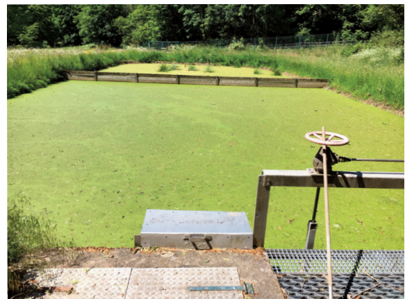
Kläranlage Rachelshausen. Quelle: ZMW, Mitarbeiter der Abteilung A
