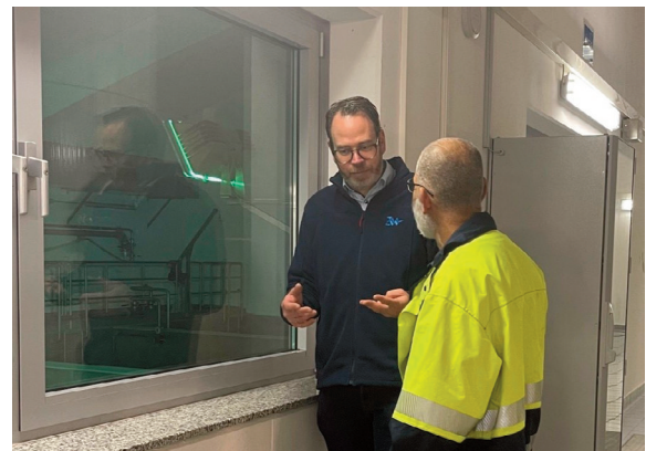
Sachgebiets- und stellvertretender Abteilungsleiter Marcus Schäfer erläutert dem „Lead Auditor“ Herrn Essam El-Rifaai die Funktionsweise der Wasseraufbereitungsanlage im Wasserwerk Stadtallendorf. Quelle: ZMW, D. Ficht
