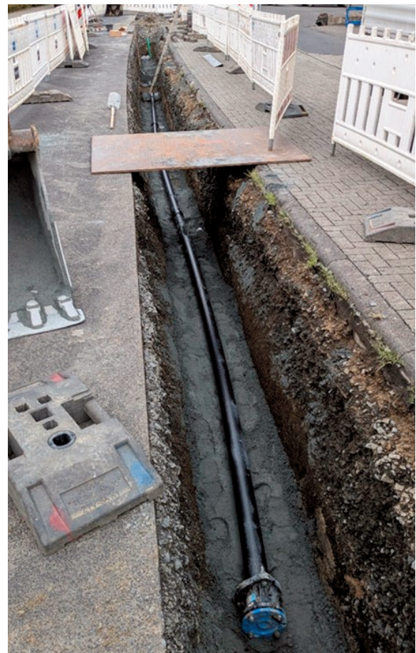
Erneuerung der Druckleitung am Schmutzwasserpumpwerk Siemensstraße. Quelle: ZMW, Mitarbeiter der Abteilung A
