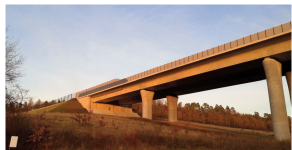
Brückenbauwerk der A 49, kurz vor der Fertigstellung. Quelle: ZMW, M. Schäfer
