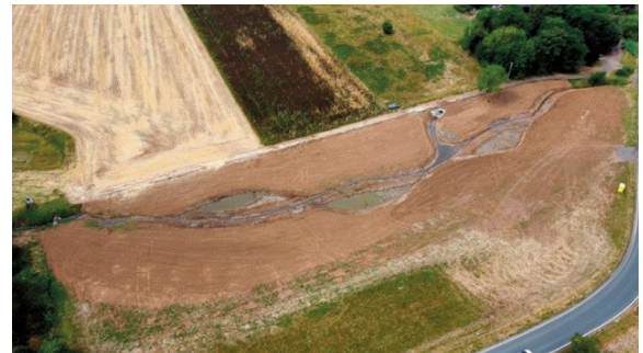
Hydraulische Dämpfungsmaßnahme am Einleitegewässer des RÜ R20. Quelle: ZMW, Mitarbeiter der Abteilung A
