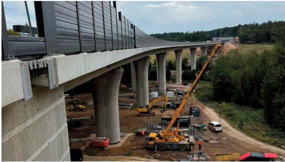
Autobahnbau BAB A49 – Arbeiten kurz vor der Fertigstellung Quelle: ZMW, M. Schäfer
