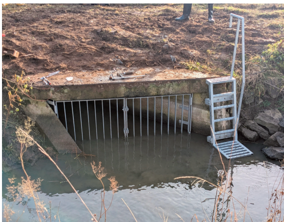
Auslauf des RÜB B25 Saasen. Quelle: ZMW, Mitarbeiter der Abteilung A
