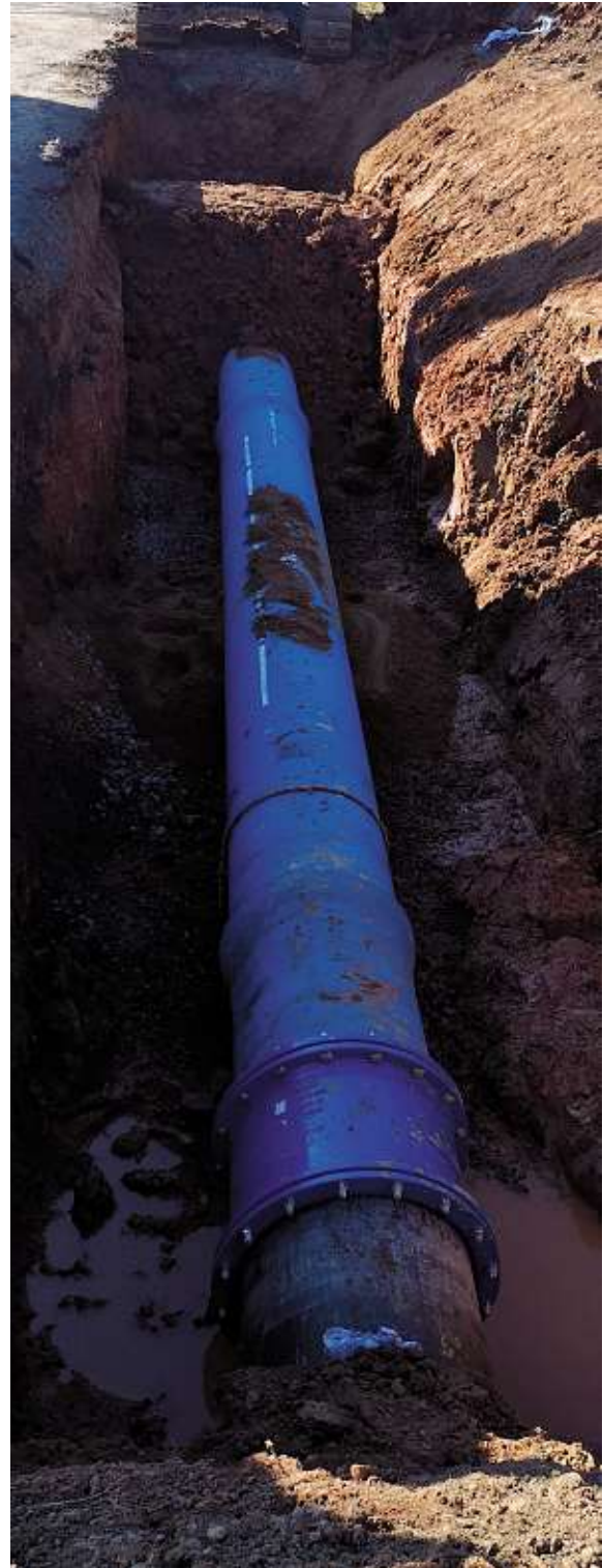
Leistungserneuerung infolge eines Rohrbruchs bei Marburg-Bauerbach im Frühjahr 2023.
