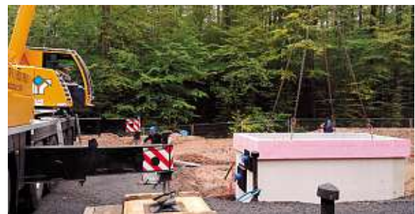
Einbau Schachtbauwerk
