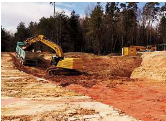
Autobahnbau BAB A49 – Eingriffe in die Deckschichten der Wasserschutzzone.
