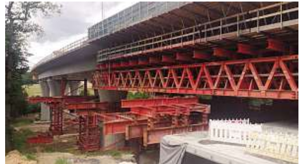
„Talbrücke Gleen“ der A49 in der Wasserschutzzone bei Niederklein (sog. Bauwerk 11)
