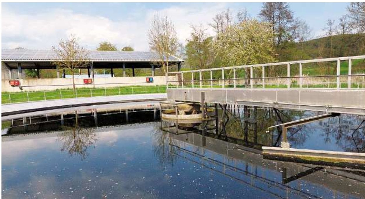
Nachklärbecken II, Kläranlage Etzelmühle
