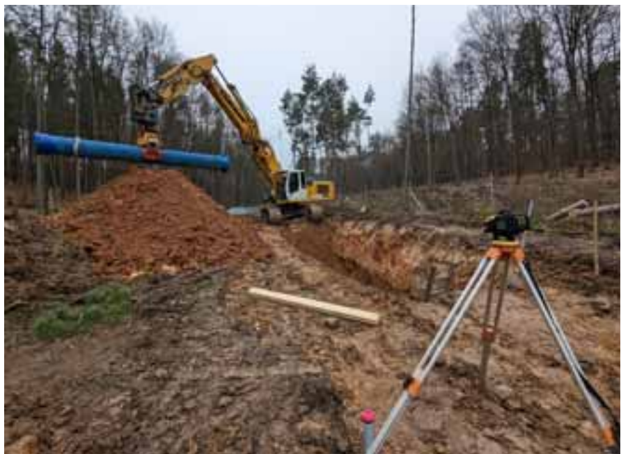
Bild 2: Leitungsverlegung DN 600
