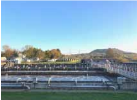
Ansicht Kläranlage Kirchhain
