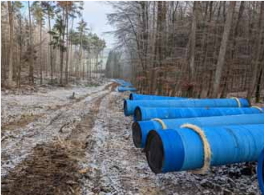
Bild 1: Vorbereitete Rohrleitungstrasse mit Rohrlager
