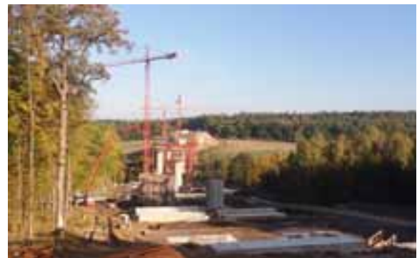
BAB49 – Der Bau des größten Brückenbauwerks – der Gleentalbrücke – schreitet schnell voran.
