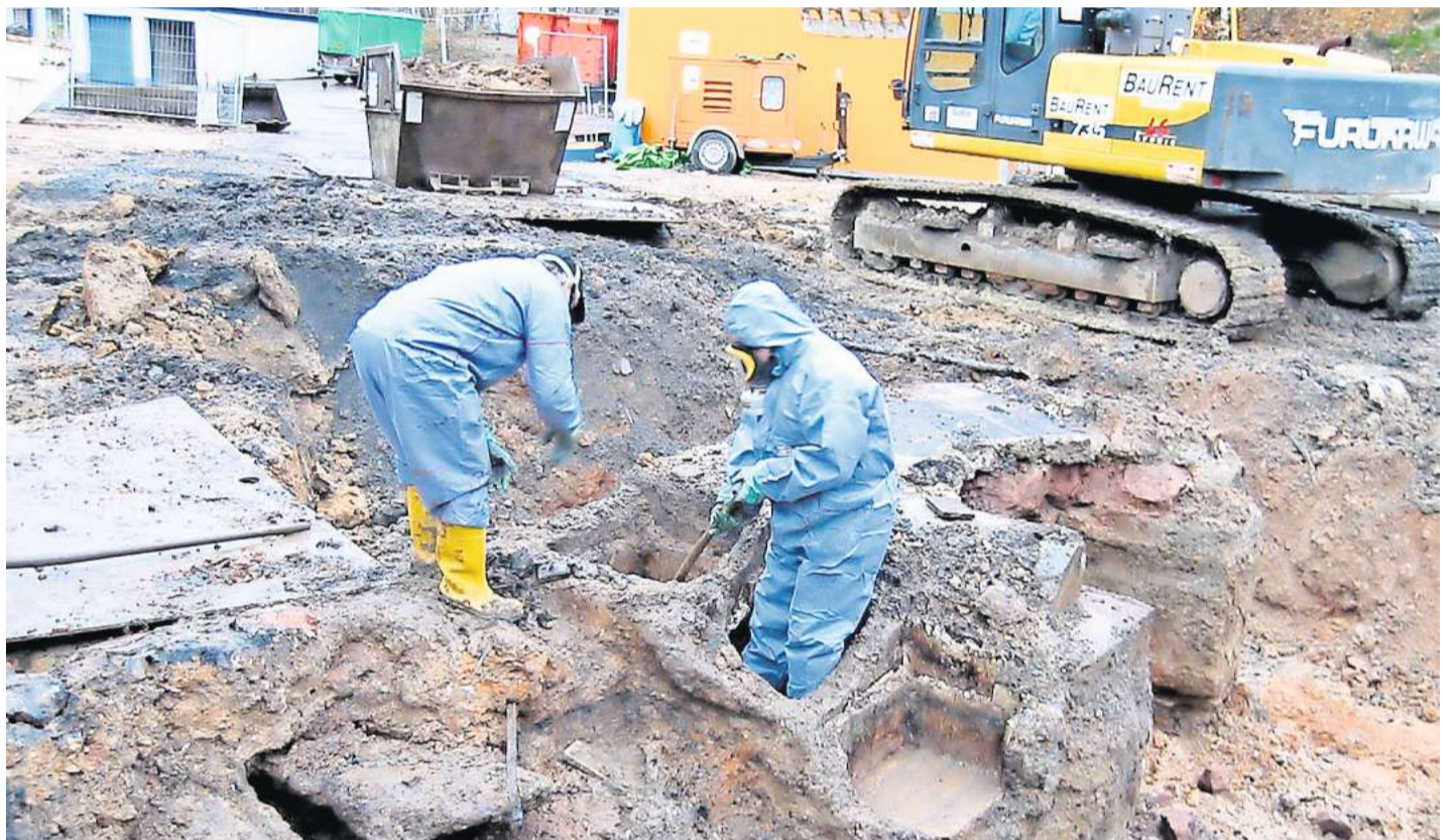
Fachleute sanierten eine Altlast bei Stadttallendorf. In einem gefälschten Schreiben warnt jetzt angeblich die Stadt vor Verseuchung des Trinkwassers. Schuld soll die A49 sein.
